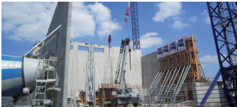
▶ **Béton autoplaçant supprimant la vibration.**
