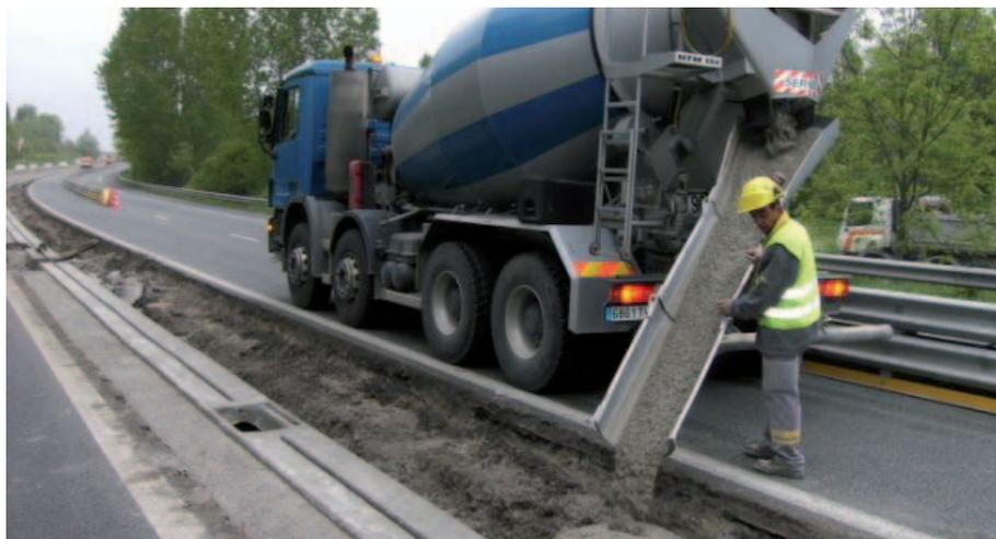
▶ **Mise en place rapide par simple déversement, sans compactage ni vibration.**
